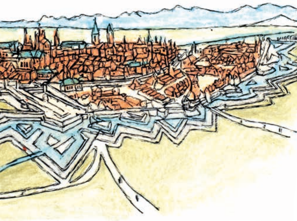
Schon von weitem sahen die Reisenden den hohen Nordturm des Straßburger Münsters.
